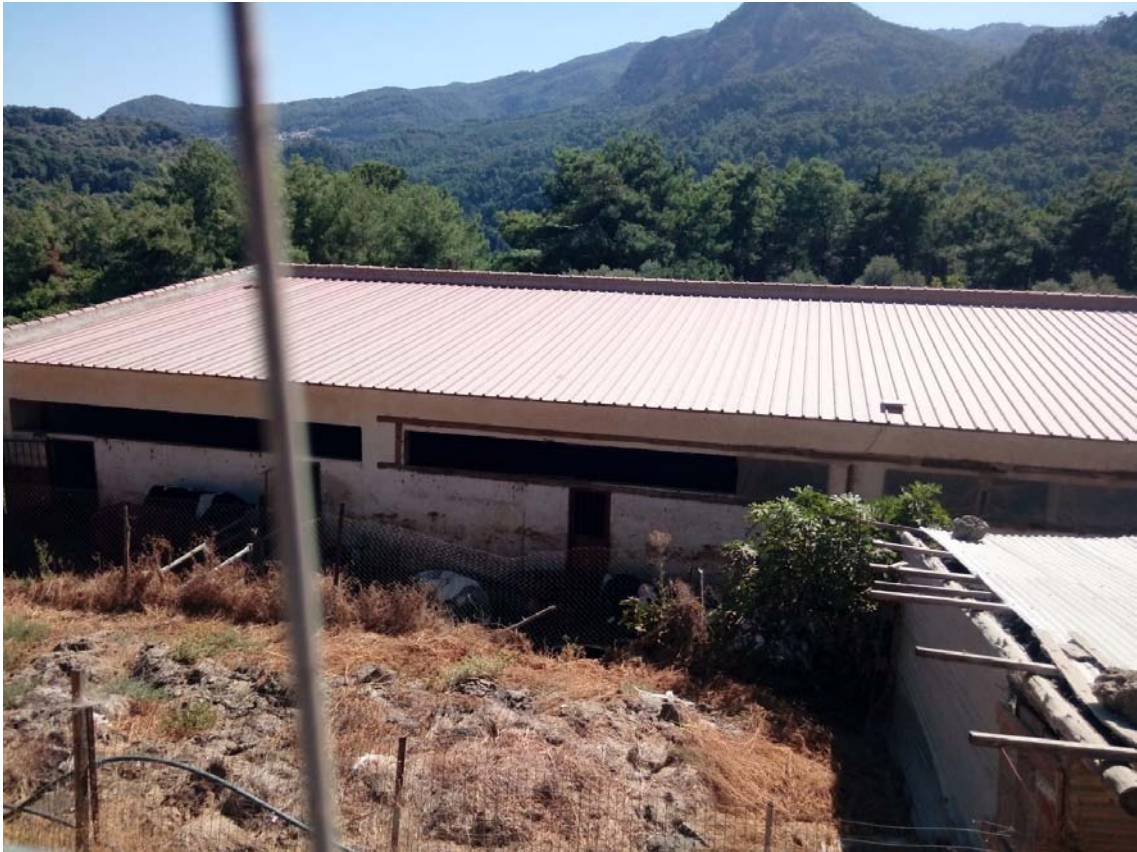
Bild 9: Kühe auf Betonböden: heiß und matschig
